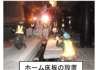
ホーム床板の設置
