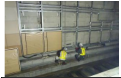
対向壁の設置（南流山駅工事時）
