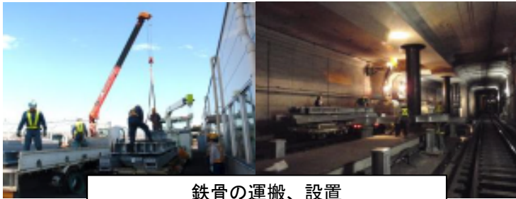
鉄骨の運搬、設置
