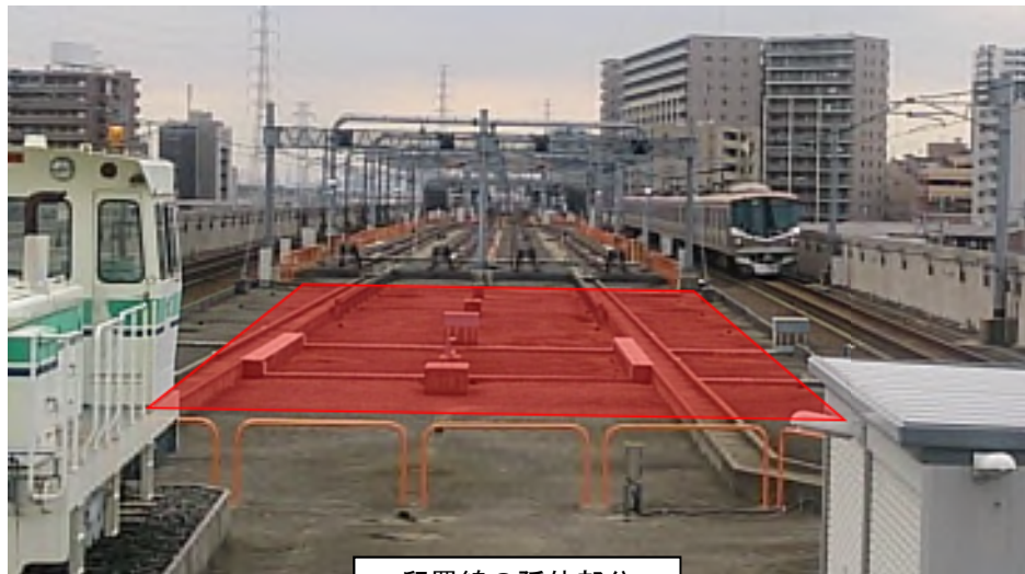
留置線の延伸部分
